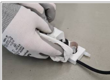
III. : 45: Nettoyer la pompe de condensat
