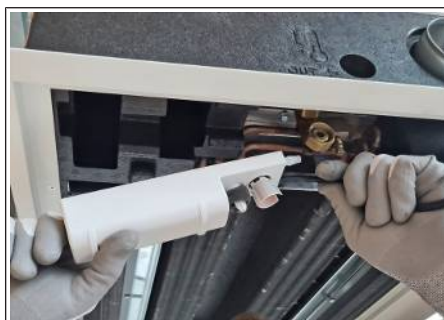
Ill. : 44: Démonter la pompe de condensat
