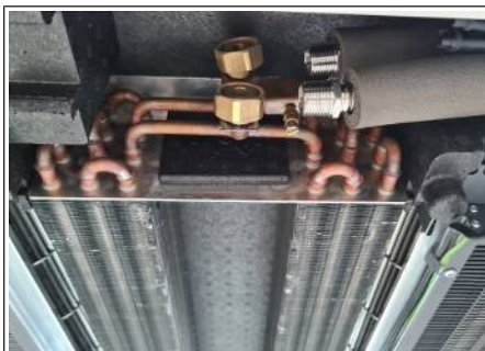
III. : 18: Isolation jusqu'au filetage
