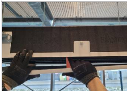
III. : 8: Pousser la tôle de protection
