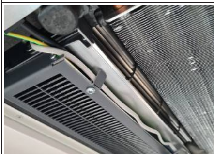
III. : 19: Poser les câbles du servomoteur
