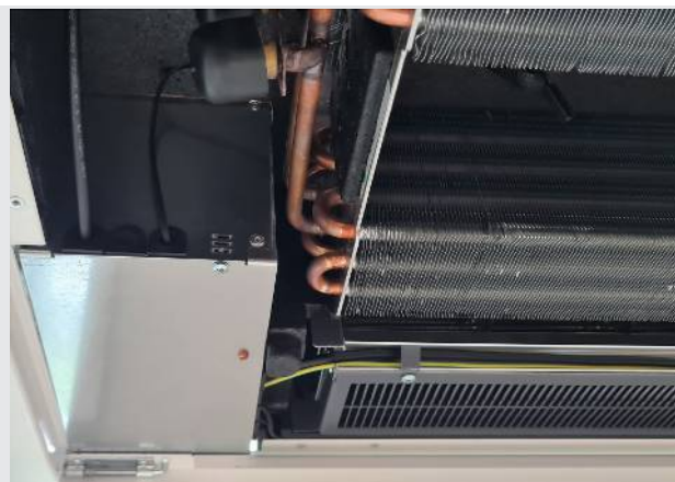
Position du boîtier de raccordement électrique (avec bac à condensat retiré)
