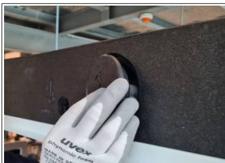
III. : 23: Retirer la tubulure d'air primaire
