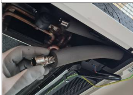
Ill. : 17: Tubes ondulés flexibles
